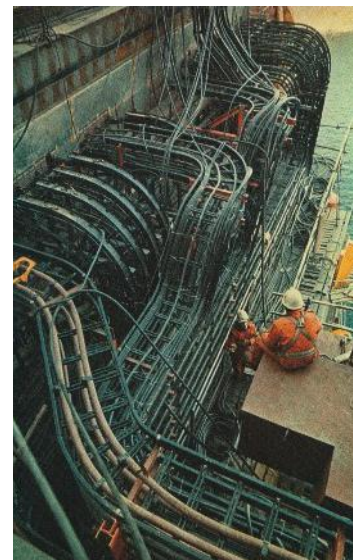
Montering av telekommunikasjonsanlegg ved oljeinstallasjon i Nordsjøen
