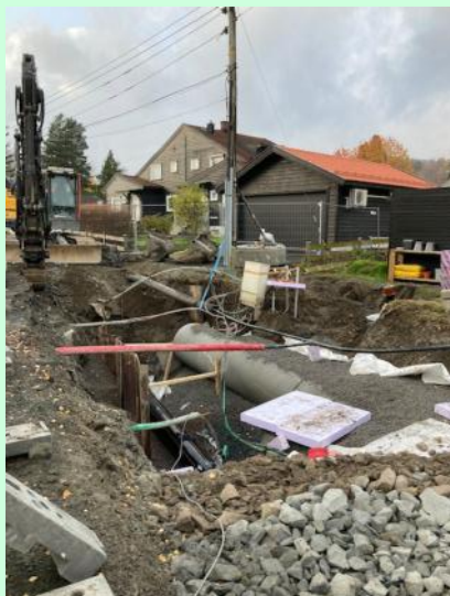
Både Dragonveien og Husarveien har vært helt eller delvis stengt i lengre perioder i løpet av året. Her i Husarveien hvor det legges ned betongrør for avløpsvann.
