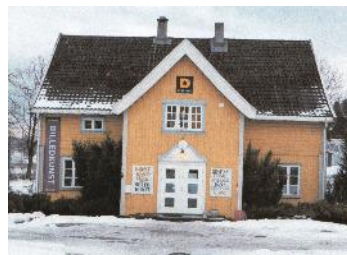
Det gamle huset med påbygget etasje, tidligere Vogellund skole.
